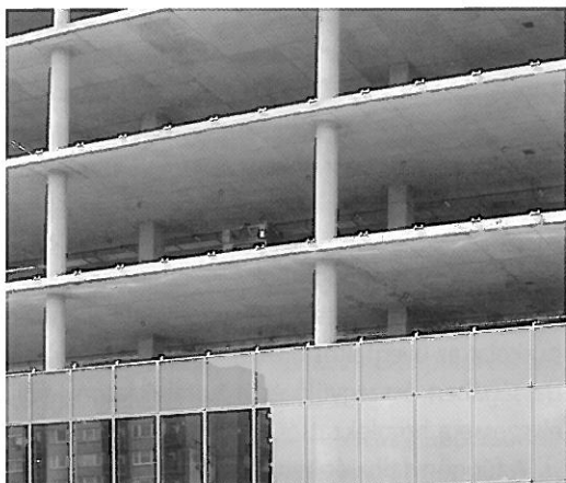
3. ábra: Parapetfal nélküli födémkialakítás
