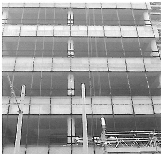
4. ábra: Parapetfalas födémkialakítás
