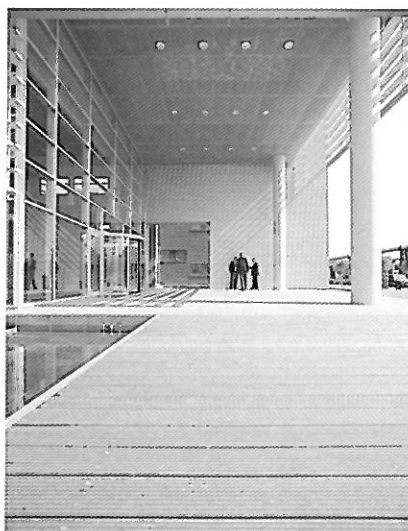
5. kép: A parkolókat és a bejárati árkádot összekötő híd képe
