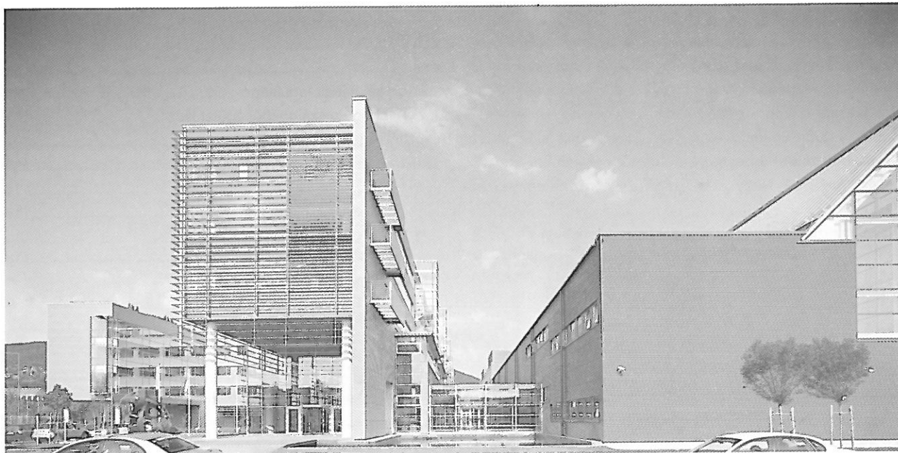
1. kép: Az új TV Székház főbejárata, jobbra a felújított, meglévő stúdióblokkal.
